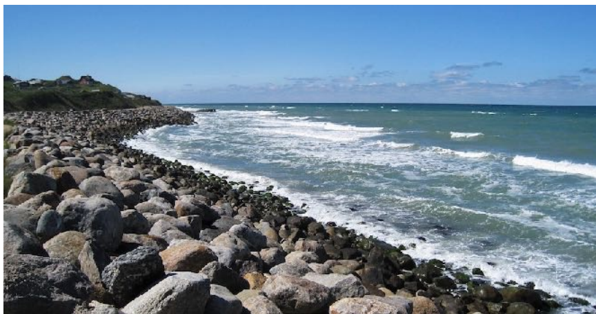
Kystsikring ved Harerenden i Lønstrup.
